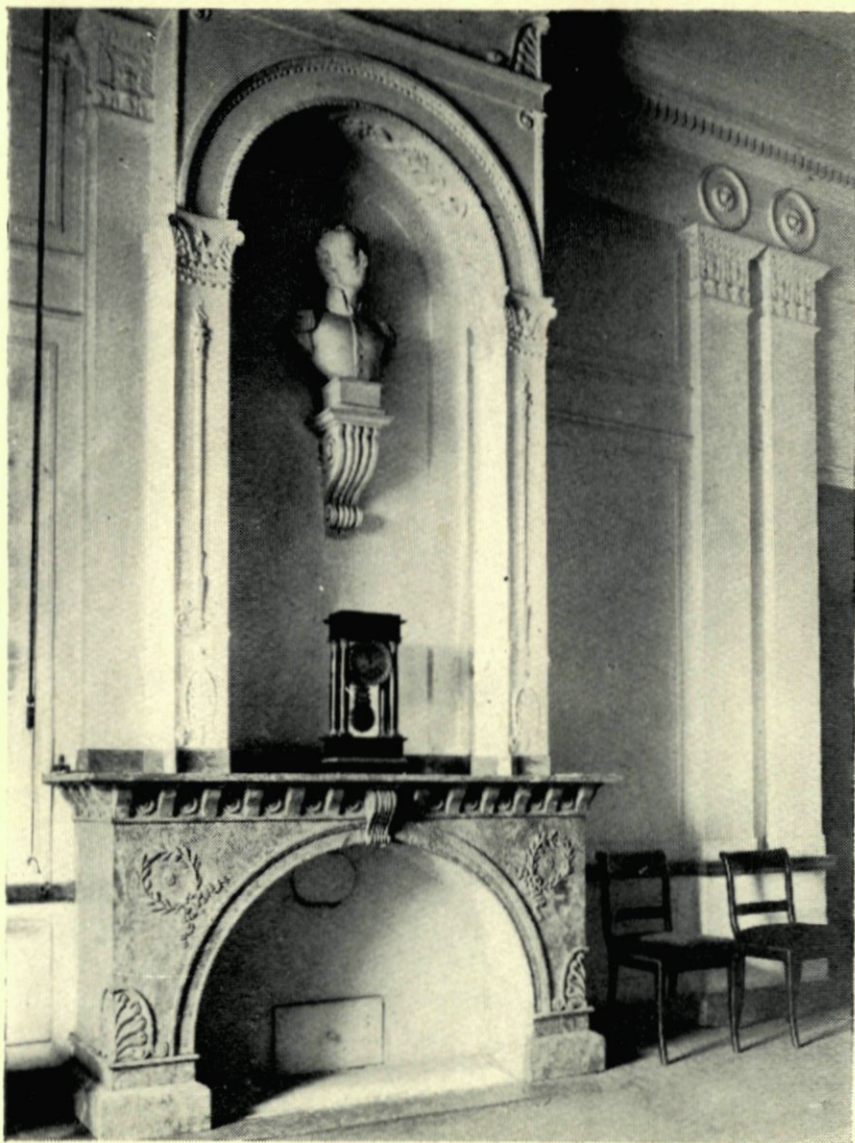
16. SCHOORSTEEN IN DE WITTE KAMER.
