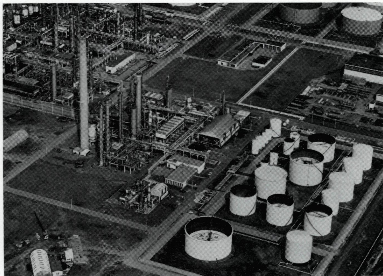
32. Haventerrein van de K.N.S.M. aan de Prinses Beatrix- en Prinses Margriethaven. 33. Essochemie.
