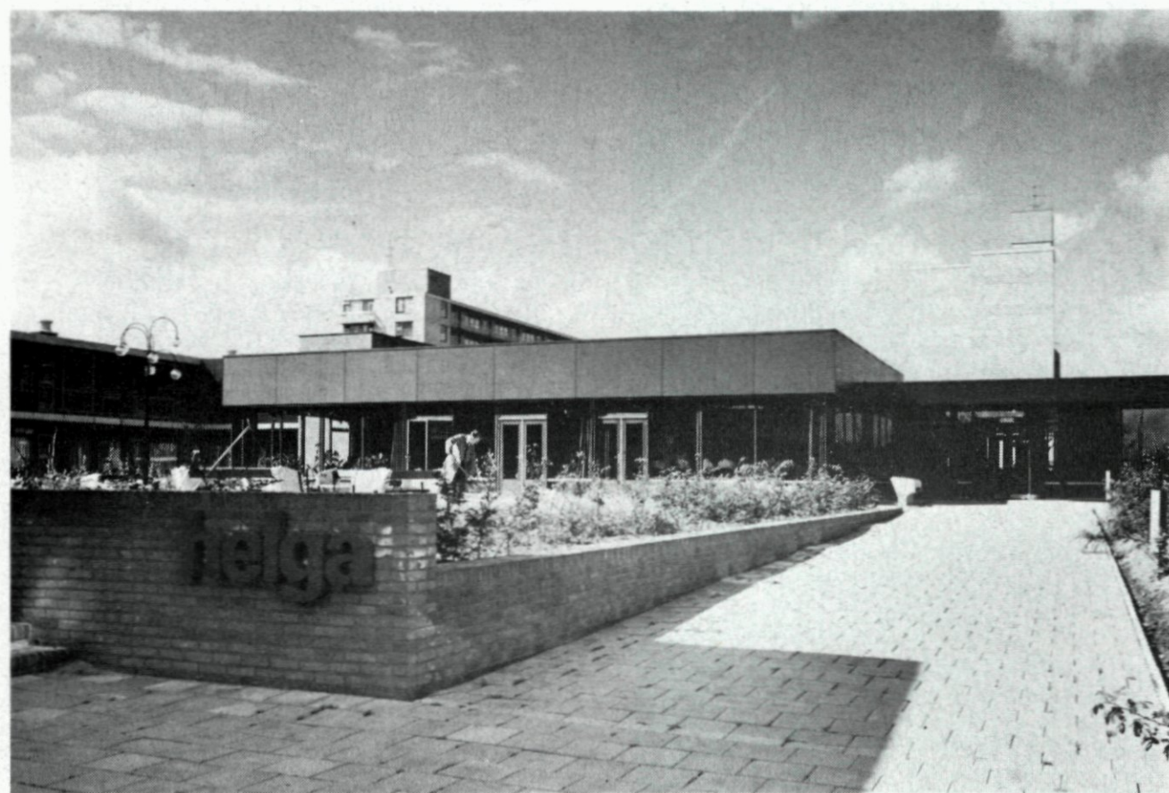
6. School en internaat van de Prof. dr. J. H. Gunning-vereniging aan de Berberisweg, geopend 26 januari. 7. Bejaardencomplex 'Helga' aan de Hendrick Staetsweg, Pr. Alexanderpolder, geopend 26 februari.
