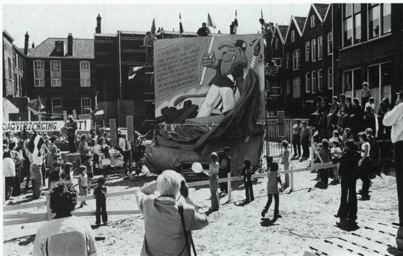
16. Wethouder mr. J. Mentink metselt een koker in de (oude) oprit van de Willemsbrug, die ook voor de nieuwe oeververbinding zal dienen, Binnenstadsdag 21 mei. 17. Het slaan van de eerste paal voor het bejaardenhuis 'De Leeuwenhoek' van 'Humanitas' aan de West-Kruiskade/hoek Sint Mariastraat, 27 mei.
