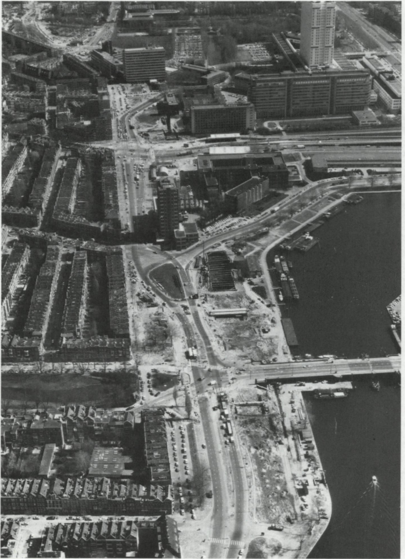
12. Aanleg van de metrolijn Oost-West, overzicht van de Rochussenstraat uit westelijke richting, rechts onder de Pieter de Hoochbrug; opname 10 april.
