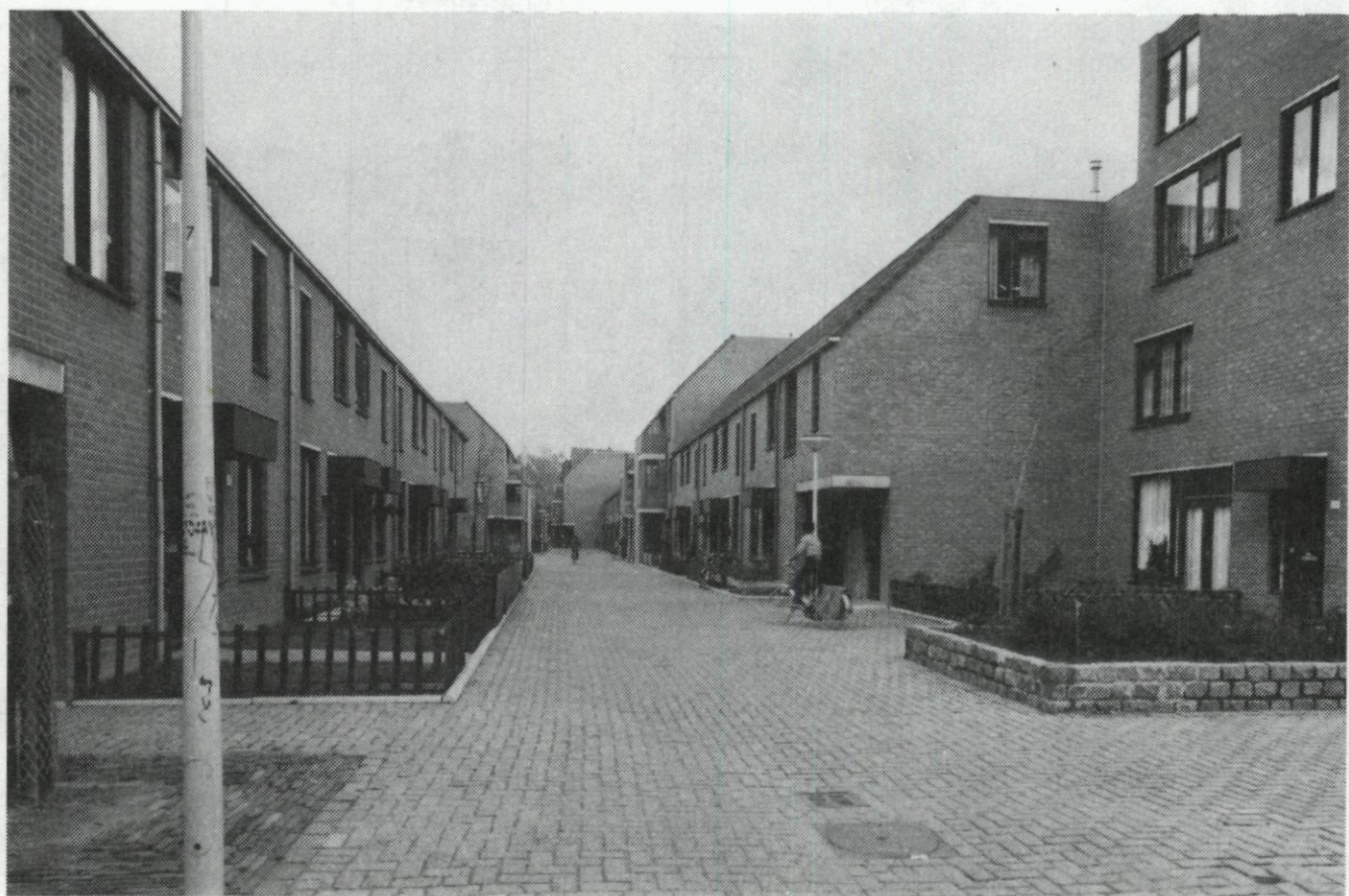
37. Nieuwbouw aan Noordplein en Rechter Rottekade, rechts de Noorderbrug; opname 1 november. 38. Nieuwbouw in Crooswijk, de Buziastraat gezien vanaf de Pisuissestraat; opname 1 november.
