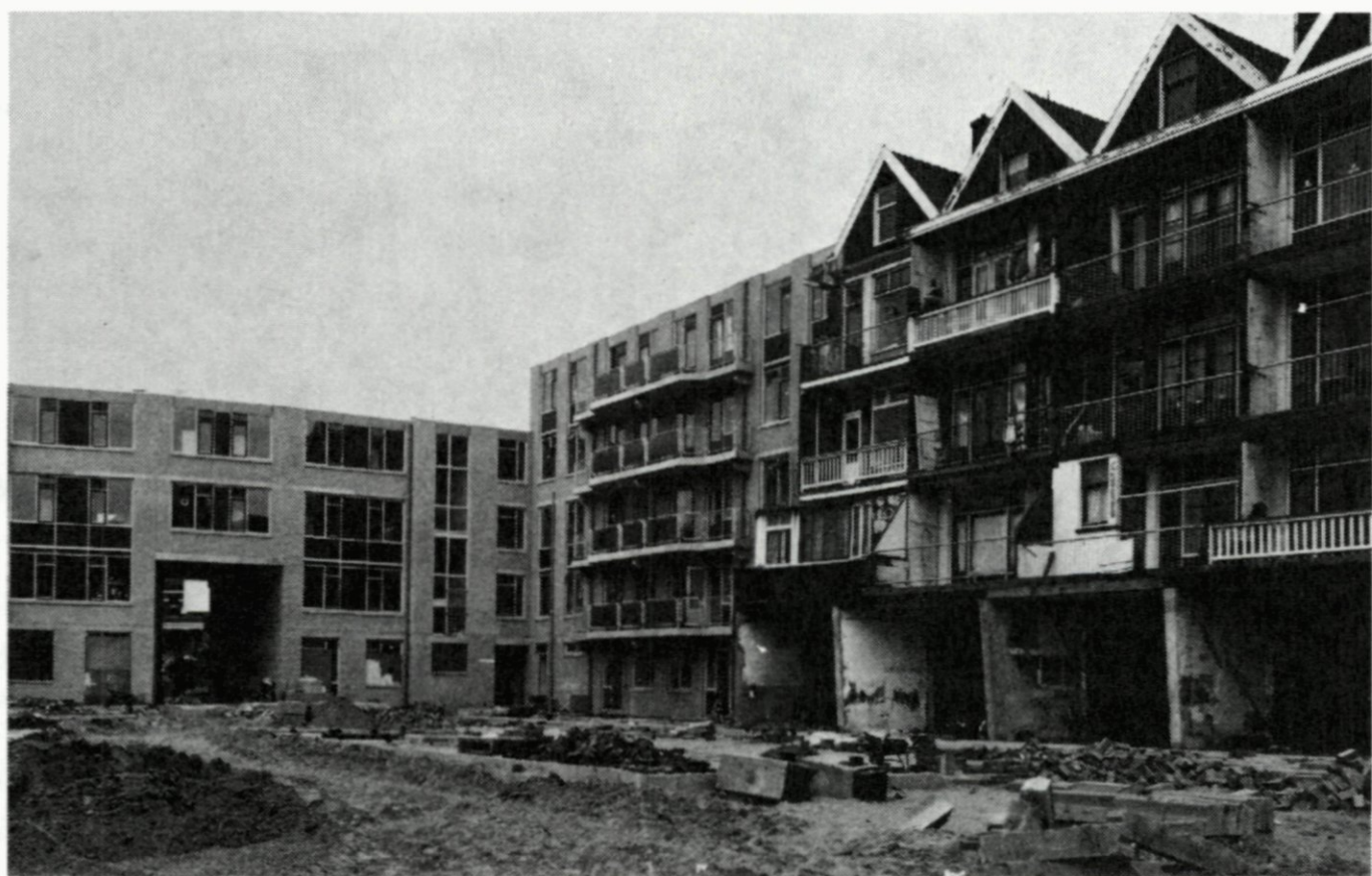
41. Open dag in de op 25 augustus in gebruik genomen warmtekrachtcentrale voor het RoCa-gebied, 28 augustus. 42. Nieuwbouw en oude woningen aan de Steinwegstraat (Afrikaanderwijk), gezien uit het zuiden, opname mei 1982.
