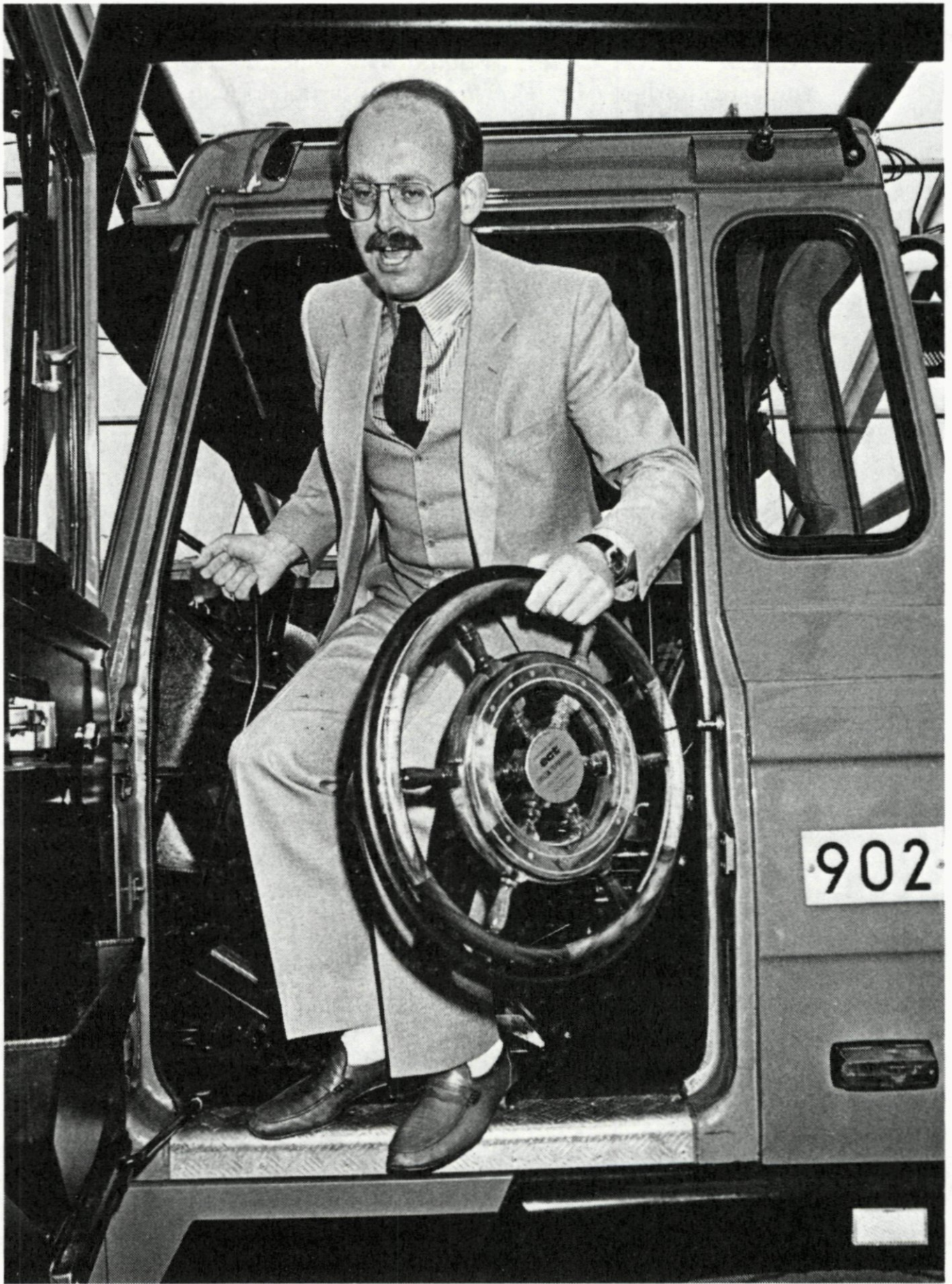
22. Als souvenir aan zijn laatste officiële daad (het beginnen van de werkzaamheden voor de bouw van een nieuwe containerterminal van de ECT) mag havenwethouder drs J. Riezenkamp het stuurwiel – in de vorm van een scheepsrad – van de door hem bestuurd trekker behouden, 28 april.
