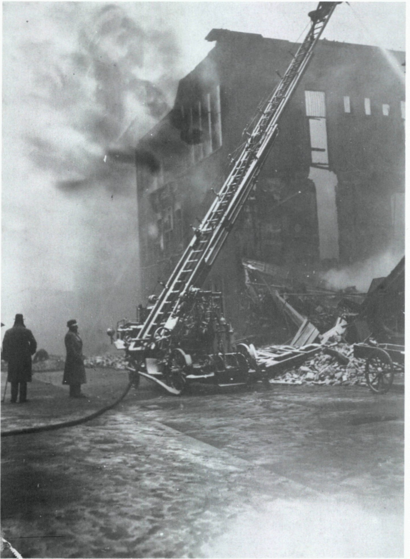
91. Brand in de tabaksfabriek van B. van der Tak & Co. in het Zwaanshals, 20/21 december 1915.
