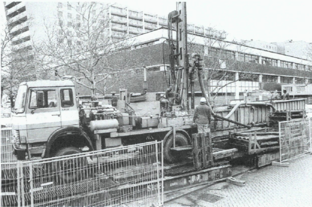
4. Aan de Hofdijk worden boorwerkzaamheden verricht voor de ondergrondse opslagplaats ten behoeve van de klimaatbeheersing van het nieuwe gebouw van het Gemeentearchief; 19 januari. Foto Cor Vos/Peter de Jong.
