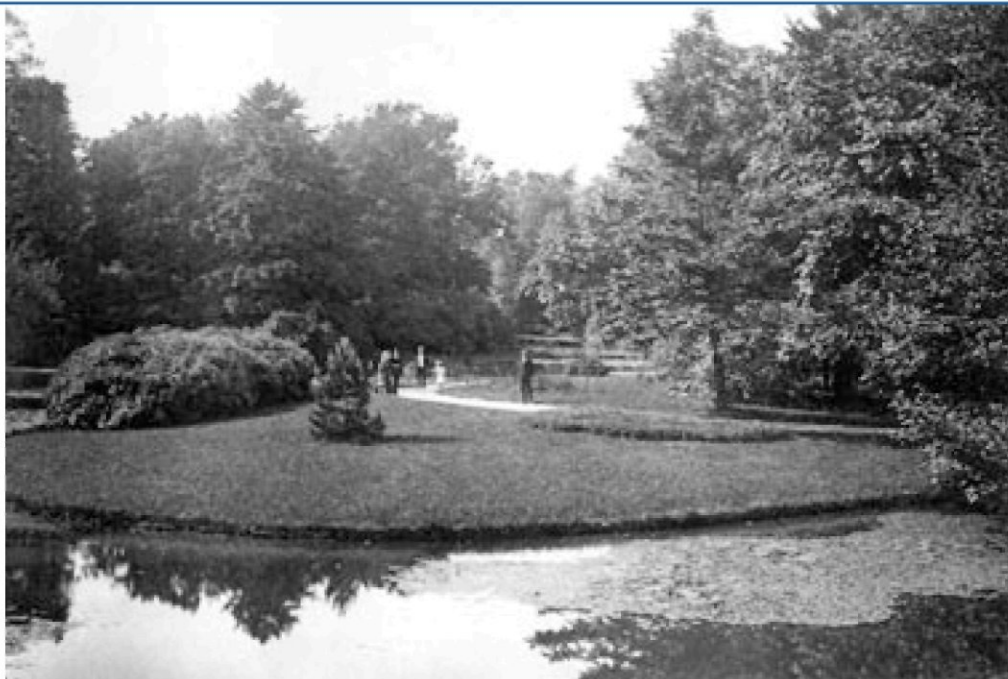
afb. 1. In 1911 publiceerde de Rotterdamse uitgeverij Ringlever en Bresser een Album van Rotterdam, vrijwel geheel bestaande uit foto's ter promotie van het Rotterdamse bedrijfsleven. Toch zijn daarin ook enkele foto's opgenomen van de openbare ruimte, waaronder een fraai beeld van Het Park. (HMR bibliotheek, RCc 6, 89)
