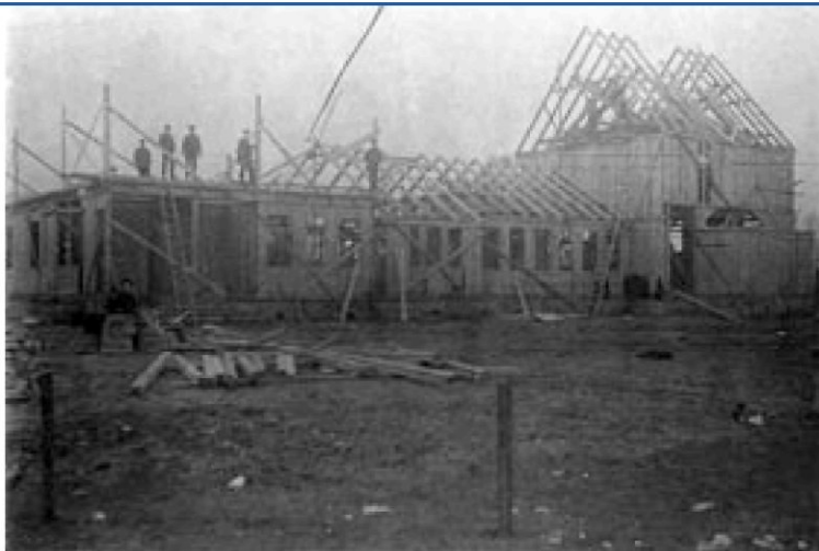
afb. 7. Foto van de kerk in aanbouw, gemaakt op 16 februari 1914. De bouw van de kerk werd uitgevoerd door het Noorse bedrijf Strømmen Trævarefabrik, dat gespecialiseerd was in het leveren van 'bouwpakketten' voor houten gebouwen. De planken werden op maat gezaagd en per schip vervoerd naar Rotterdam. Timmerlieden van het bedrijf reisden mee om de kerk ter plaatse op te bouwen. De inwijdingsceremonie vond plaats op 26 juli 1914. (foto in archief Sjømannsmisjonen, Statsarkivet Bergen)
