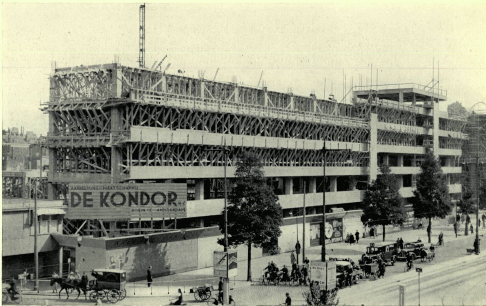
6. Stand der werkzaamheden aan den Beursbouw in September 1938. Foto Rotterdamsch Nieuwsblad.
