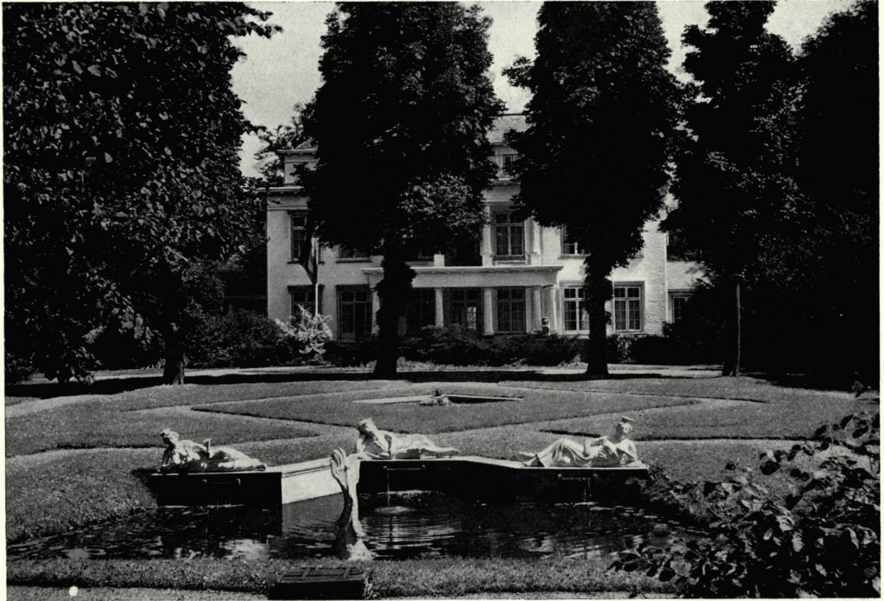
21. De buitenplaats „De Tempel” na de restauratie, in 1949. Foto Openbare Werken.
