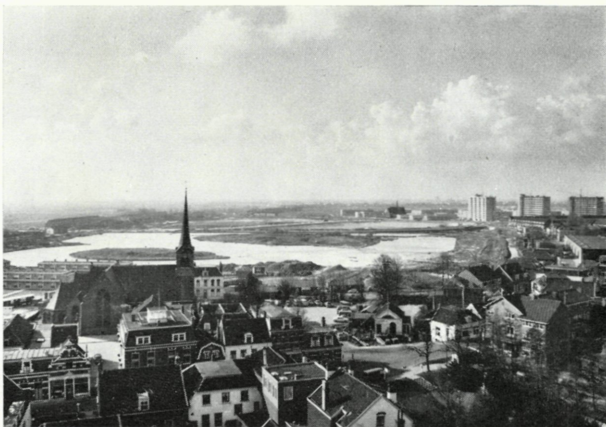
19. Metro-bouwdok op het eiland Van Brienenoord; foto Openbare Werken. 20. De werkzaamheden voor de Van Brienenoordbrug, gezien van de watertoren in IJsselmonde. In het midden de opspuitingen voor de bouw van de zuidelijke opritten van de brug; foto Anefo.
