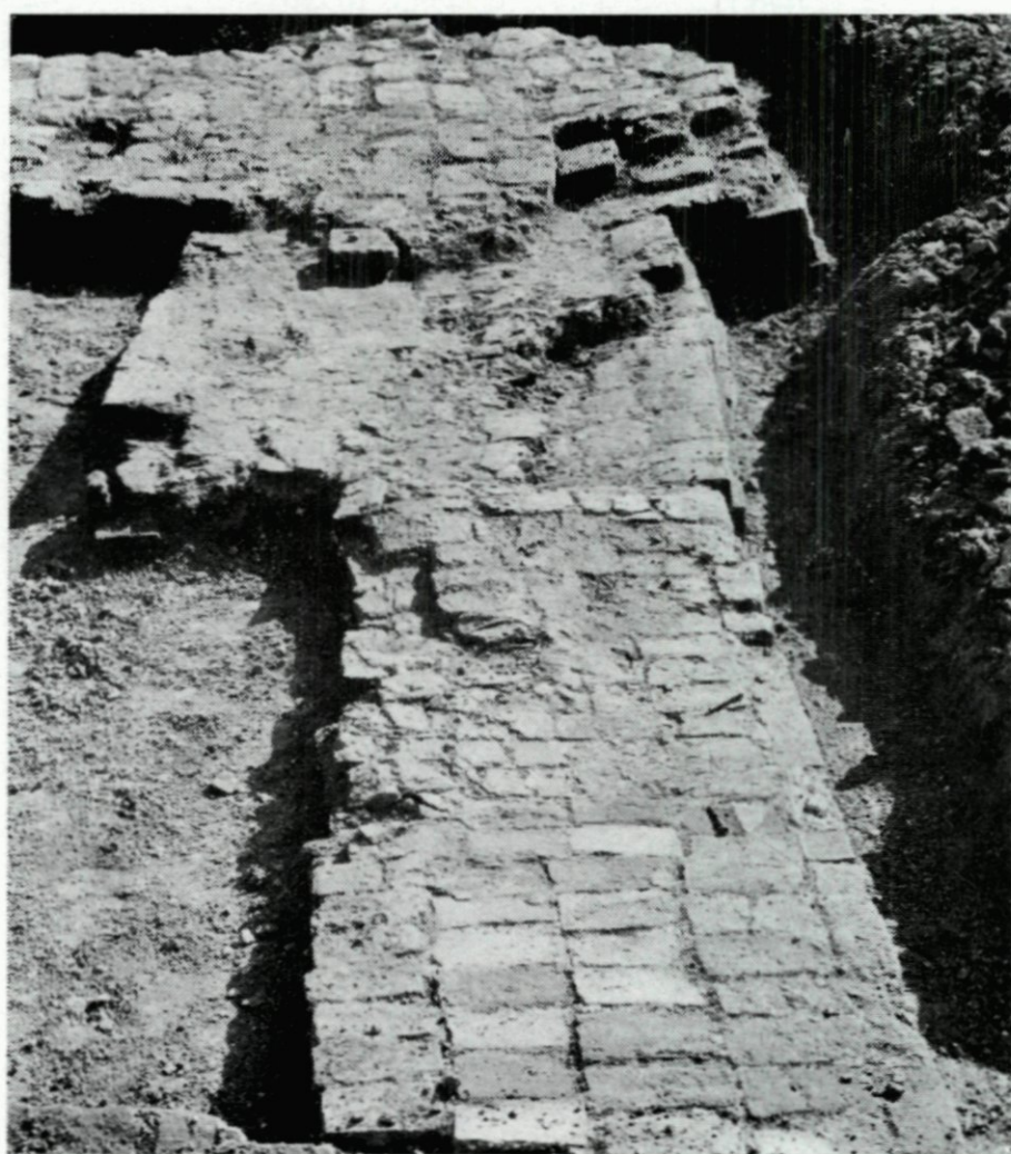
34-35. Vlaardingen. Opgraving Holij. Fundering van de woontoren. Eén van de spaarbogen is dichtgemetseld met kleine steen.
