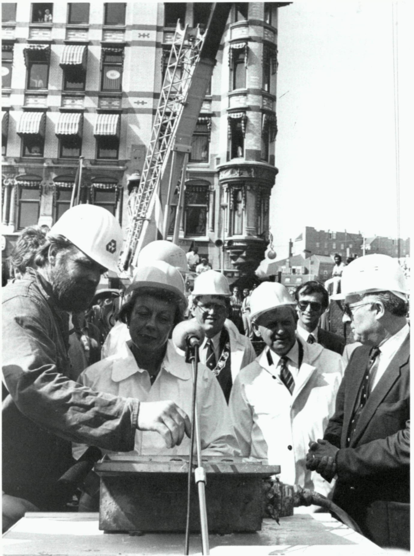
12. Minister mevr. drs. N. Smit-Kroes ontvangt instructies voor het in werking stellen van de heimachine waarmee het eerste stuk damwand voor de Spoortunnel Rotterdam wordt geslagen; 28 april.
