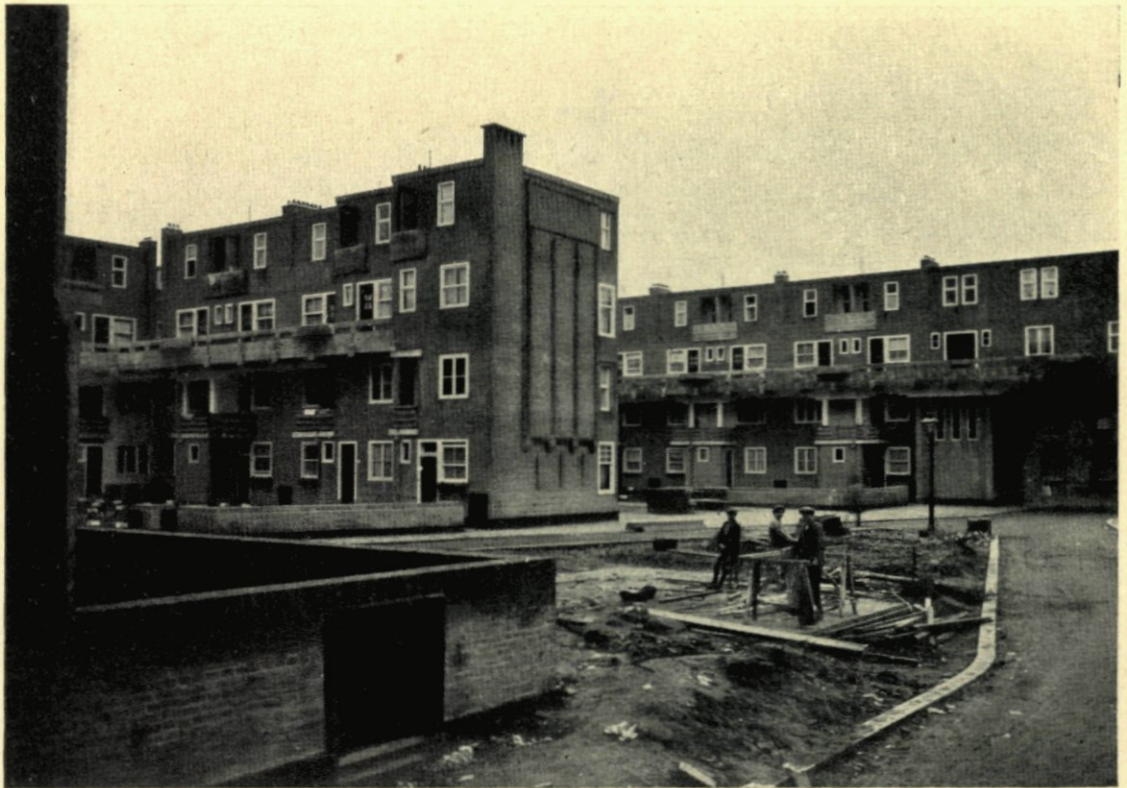
3-4. GALERIJBOUW IN DEN POLDER SPANGEN FOTO GEMEENTEWERKEN
