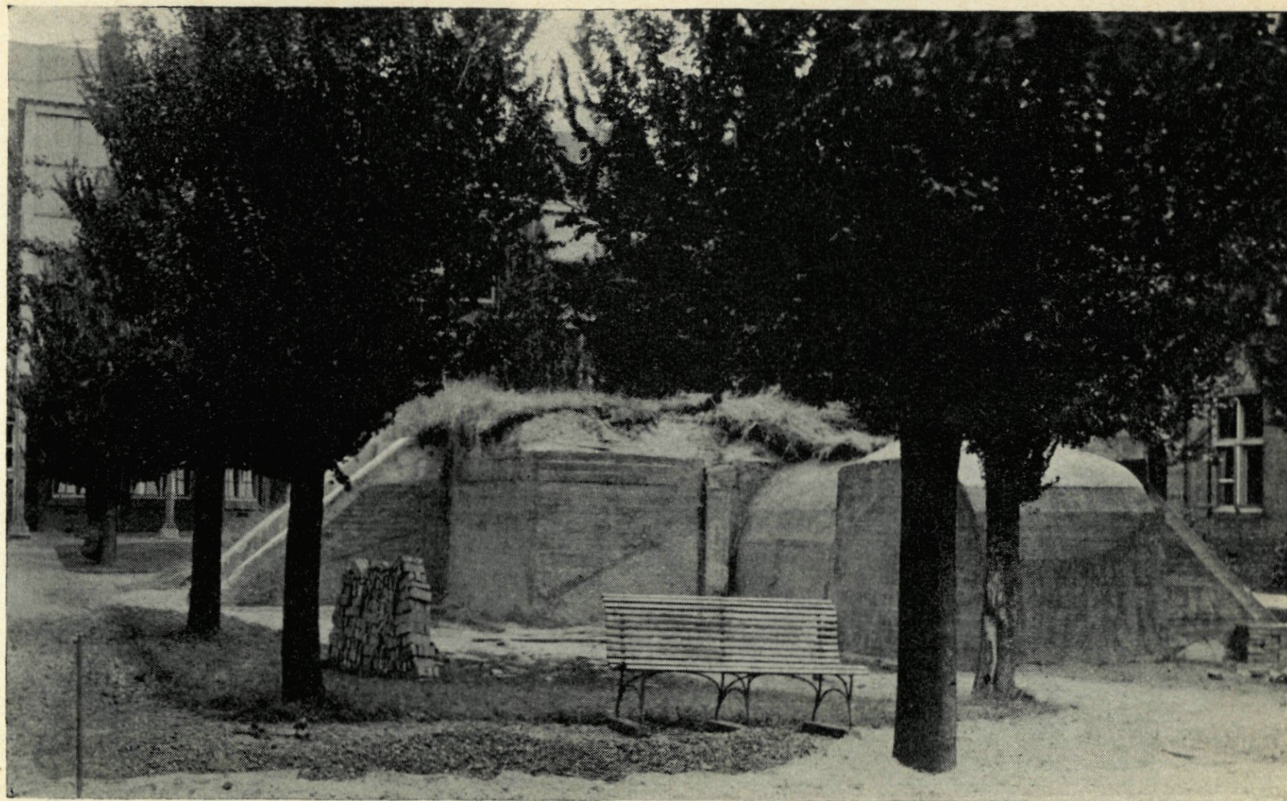
31. Duitse schuilkelder in den tuin van het Ziekenhuis aan den Bergweg ontmanteld. Juni 1945.
