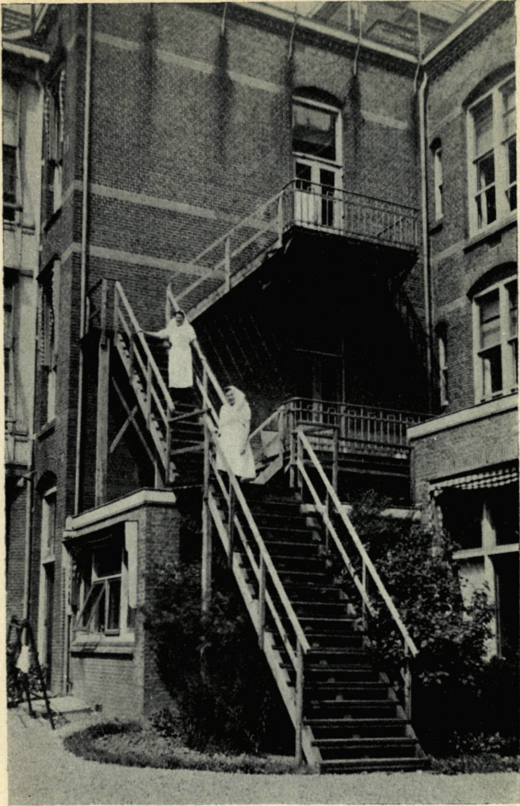
29. Vlucht-nood-trap, in 1940 gebouwd, aan een der vleugels van het Ziekenhuis aan den Bergweg.
