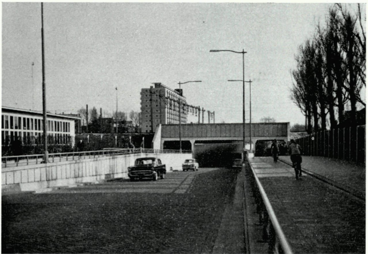
6. Opening van het nieuwe politiebureau aan het Marconiplein door burgemeester Van Walsum, 15 april. Aanbieding van een tekening voor het nieuwe gebouw; foto A. Groeneveld. 7. Diergaardetunnel; foto J. F. H. Roovers
