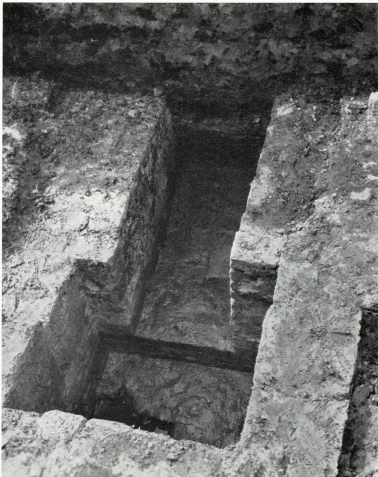
26. Het kasteel Valckensteyn; het gemak, met uitstroomopening, tegen de westelijke walmuur; foto Openbare Werken.
