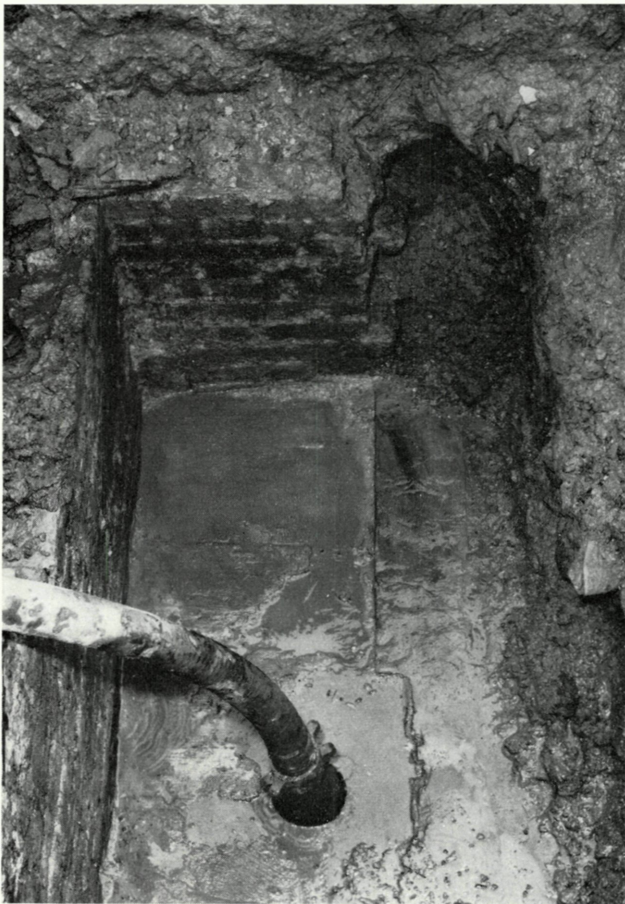
27. Het kasteel Valckensteijn; het gemak van de donjon gezien vanuit het oosten, de houten vloer is zichtbaar, de noordelijke wand is geheel weggebroken; foto Openbare Werken.
