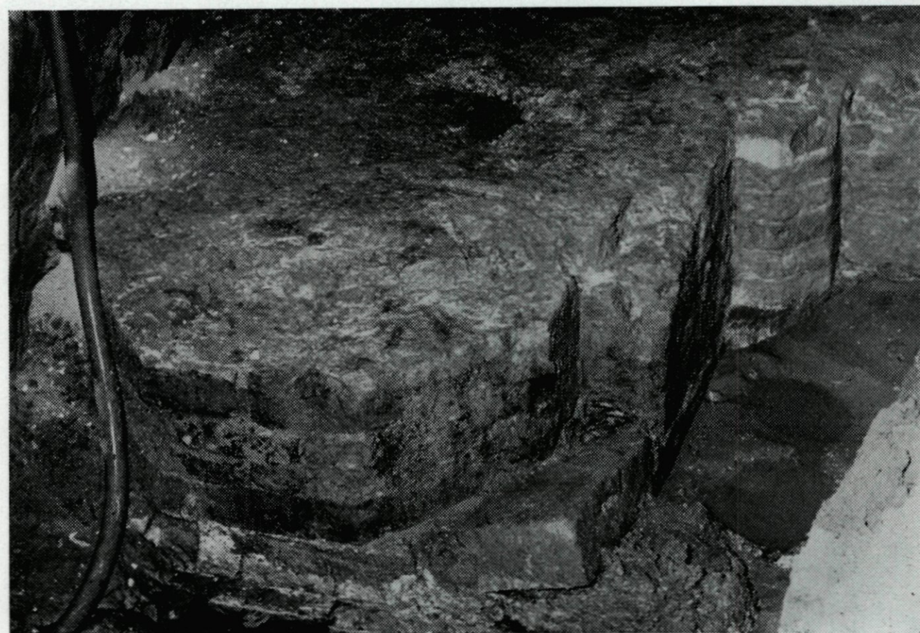
37. Vlaardingen, Grote Kerk. Tufsteen muur in gietwerktechniek tussen koor en noorder zijkapel.
