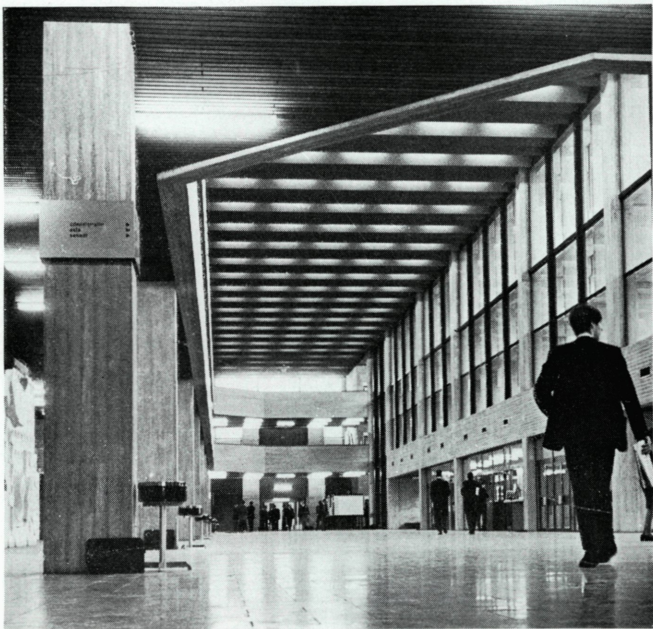
20-21. Het nieuwe gebouw van de Nederlandse Economische Hogeschool aan de Kralingse-dreef (nu Burg. Oudlaan), in aanbouw (HV); de grote hal (HVV).
