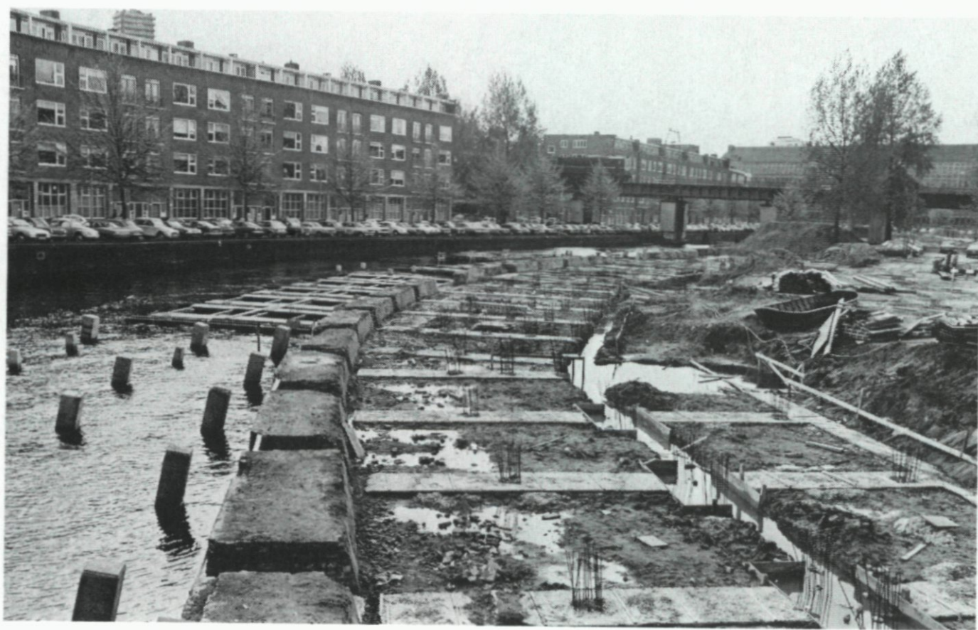
14. Metrobouw. 'Kaalslag' in Kralingen, het terrein voor het te bouwen metrostation Voor- schoterlaan, op de achtergrond de toren van de Hervormde Kerk aan de Hoflaan, opname 9 mei. 15. Fundering, gedeeltelijk in het Stokviswater, voor de bouw van woningen aan de Sint Jacobsplaats, opname 12 mei.
