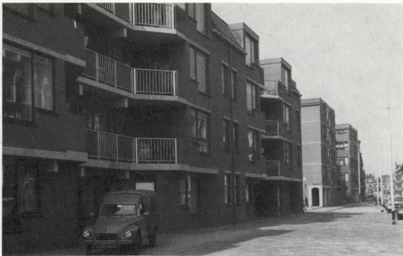
13. Het restant (uit de grond getrokken palen) van de huizen aan de westzijde van de St. Mariastraat, links de achterkant van de nieuwe woningen aan de Gaffelstraat. 14. Nieuwbouw aan de Banierstraat, de eerste straat links is de Paap Dirckstraat, op de achtergrond de Walenburgerweg. Opnamen april 1981.
