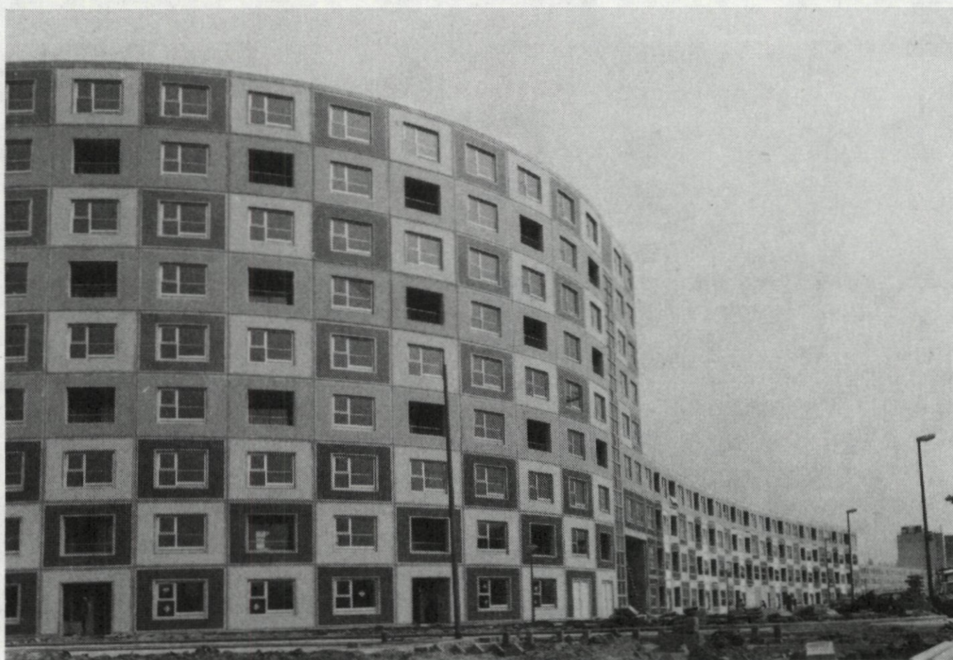
23. Nieuwe huizen tussen Voorhaven en Achterhaven in Delfshaven, rechts de romp van de molen 'De Distilleerketel'. 24. Woningcomplex 'de Paperclip', tussen Binnenhaven en Rosestraat, in aanbouw. Opnamen maart 1982.
