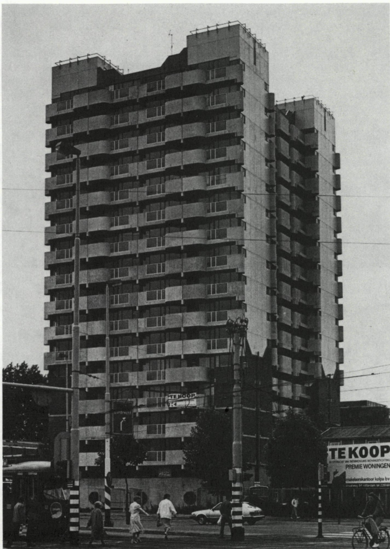
29. Woonflat 'Delftse Poort' aan het Hofplein, opname juni 1981.
