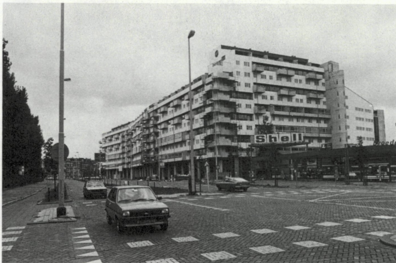
32. Nieuwbouw op het voormalige Heliport-terrein aan het Pompenburg, gezien vanaf de Adm. de Ruyterbrug, opname juni 1981. 33. Complex woningen en bedrijfsruimten aan het Weena tussen Conradstraat en Statentunnel, opname oktober 1981.
