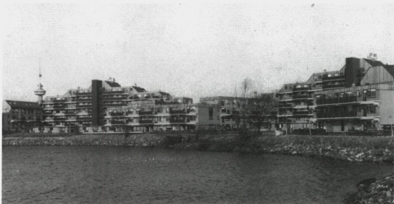
57. Stadsvernieuwing in het Rottekwartier: de Vriendenlaan (r.) en het Stroveer (l.), op de achtergrond de Hofdijk met r.k. kerk 'Het Bosje', wisselwoningen en het gebouw van Voormolen.
