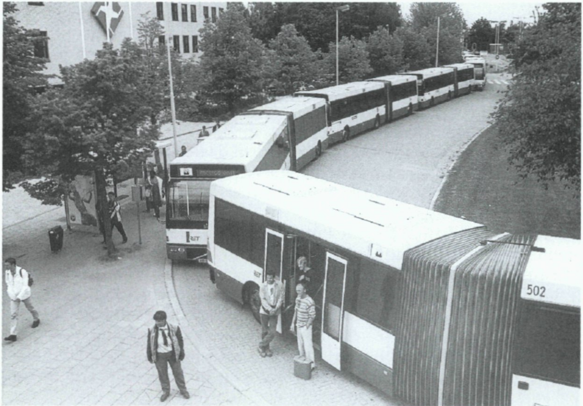
9. Tijdens de werkzaamheden aan het afgraven van de aarden metrobaan bij Pendrecht worden tussen de metrostations Slinge en Poortugaal pendelbussen ingezet; 22 mei. Foto Cor Vos/Aad v.d. Vorm.
