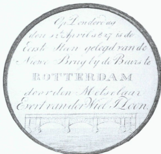
39. Achterzijde van de penning met de vermelding van de eerstesteenlegging. Foto Historisch Museum Rotterdam.
