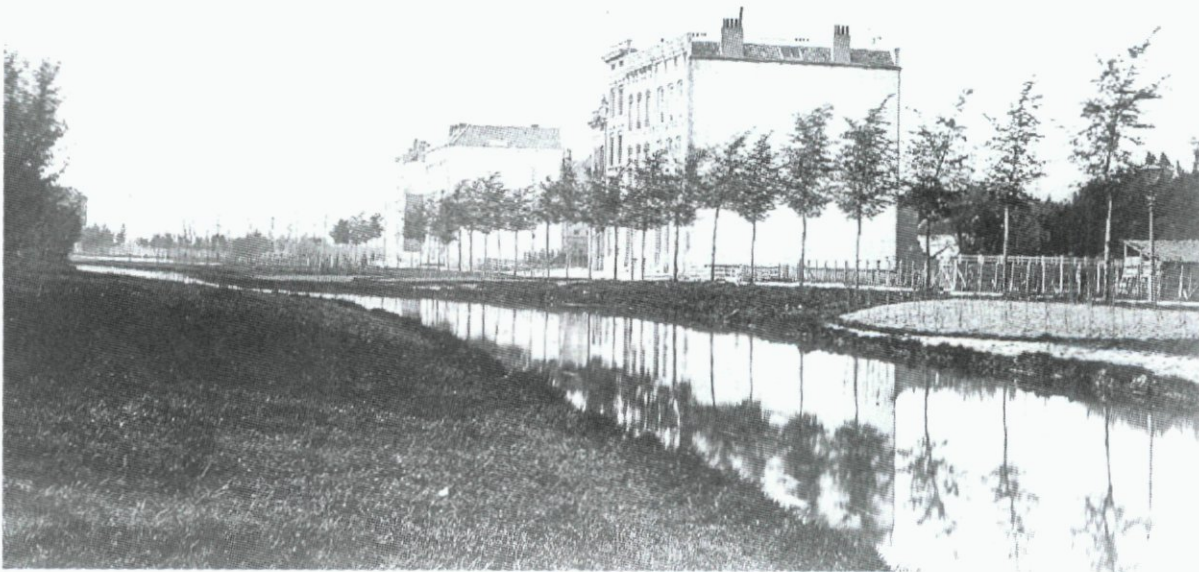
40. Aan de singels van het Waterproject verrezen fraaie villa's, maar de bewoners van de singels moesten tot hun schrik ervaren dat deze hoofdafvoer van het stedelijk rioolstelsel niet helemaal aan de verwachtingen beantwoordde. De stank was er veelal ondraaglijk (foto Gemeentearchief Rotterdam).
