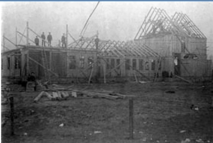
afb. 7. Foto van de kerk in aanbouw, gemaakt op 16 februari 1914. De bouw van de kerk werd uitgevoerd door het Noorse bedrijf Strømmen Trævarefabrik, dat gespecialiseerd was in het leveren van 'bouwpakketten' voor houten gebouwen. De planken werden op maat gezaagd en per schip vervoerd naar Rotterdam. Timmerlieden van het bedrijf reisden mee om de kerk ter plaatse op te bouwen. De inwijdingsceremonie vond plaats op 26 juli 1914. (foto in archief Sjømannsmisjonen, Statsarkivet Bergen)
