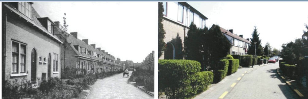
afb. 5. De Treek vóór en na de tweede fase van de stadsvernieuwing 1983-1987. De woningen werden deels bekleed met trespaplaten. (foto De Nijl Architecten, 2009)
