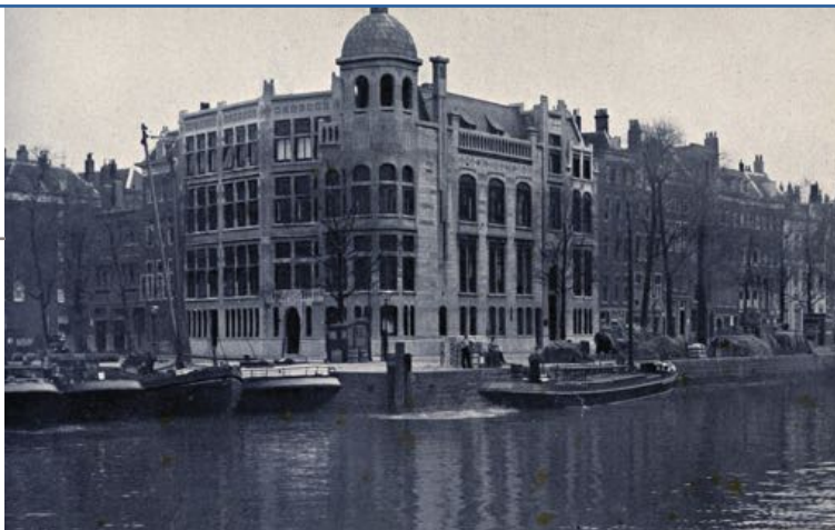
afb. 7. Het pand van Internatio aan de Wijnhaven, voor en na het bombardement van mei 1940. (foto familiebezit)
